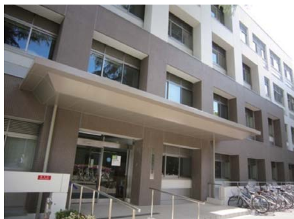
総合研究7号館の北側（玄関側）の外観
