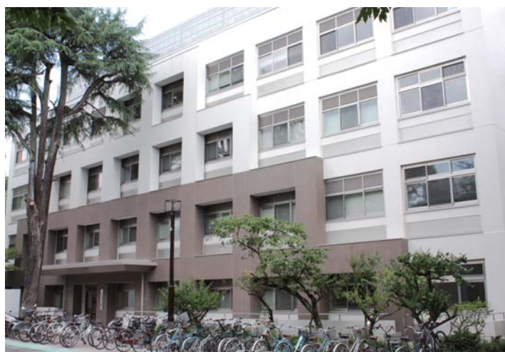
(写真:総合研究7号館(旧工学部10号館)の外観)
