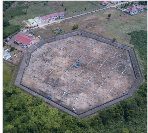
インドネシア共和国西スマトラ州の赤道直下に設置されている赤道大気レーダー。規模はMULレーダーと同程度。
