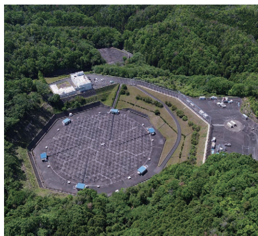
滋賀県甲賀市信楽町に設置されているMULレーダー。アンテナ直径は103m。
